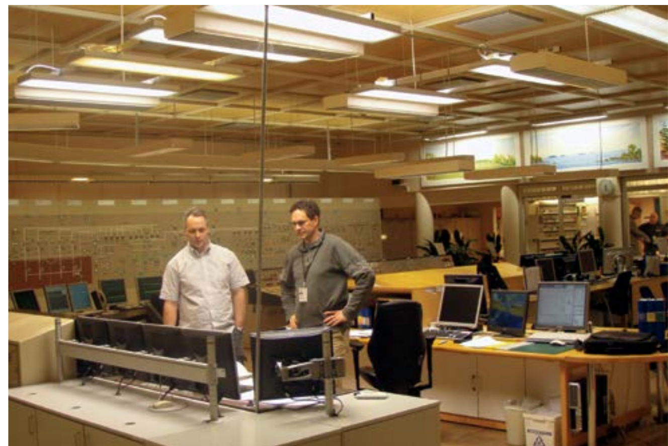
Arne Lowden, forskare, och Jan Hallqvist från Forsmark kärnkraftverk i kontrollrummet under den nya dynamiska provbelysningen för reaktoroperatörer.
